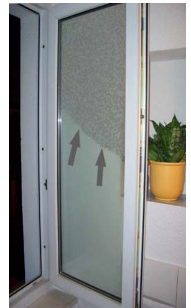
Zustand an der Scheibe nach etwa 5 Minuten Lüften. Nach etwa 10 Minuten ist das Fenster komplett trocken. Das ist ein Indikator dafür, dass die Luft im Raum jetzt vollständig ausgetauscht ist.
